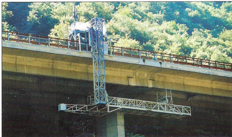
Attrezzatura MBS 230-2,4 nella fase di passaggio della pila sull'Autostrada del Brennero.
