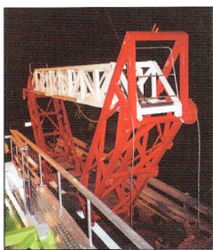
Il montaggio in notturna dell'Attrezzatura a Portale.
