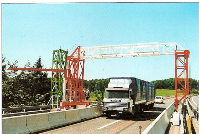
L'Attrezzatura a Portale può essere adattata alla larghezza del ponte.
