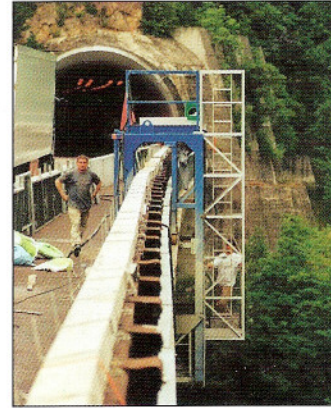
La Piattaforma per gli Sbalzi può essere impiegata in combinazione con MBS o singolarmente per lavori all'esterno della trave di bordo ed al cordolo.
