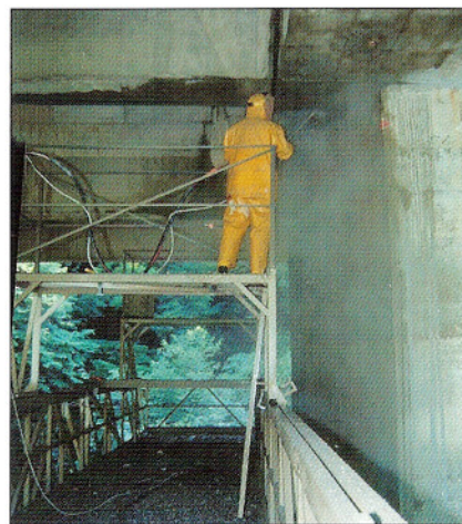
Meglio che con le attrezzature mobili (MBI) l'MBS consente l'utilizzo di attrezzi per l'idrodemolizione anche a diversi livelli.
