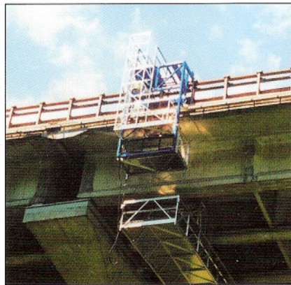
La Piattaforma per gli Sbalzi può essere impiegata in combinazione con MBS o singolarmente per lavori all'esterno della trave di bordo ed al cordolo.
