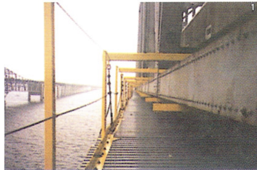
1. Piattaforma esterna sull'arcata meridionale del ponte della baia di Chesapeake, nel Maryland.
