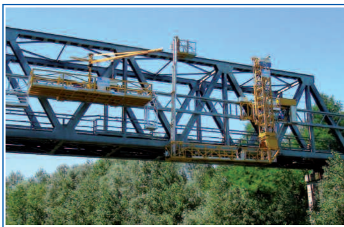
Piattaforma "Sylvia" per ispezioni e lavori ai ponti ferroviari (ponti a travata metallica a maglia triangolare a via interna) in presenza di traffico (Brevettato)
