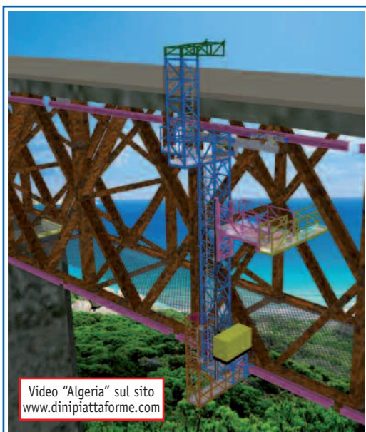
Piattaforma di servizio per i viadotti eccezionali della nuova linea ferroviaria in Algeria
