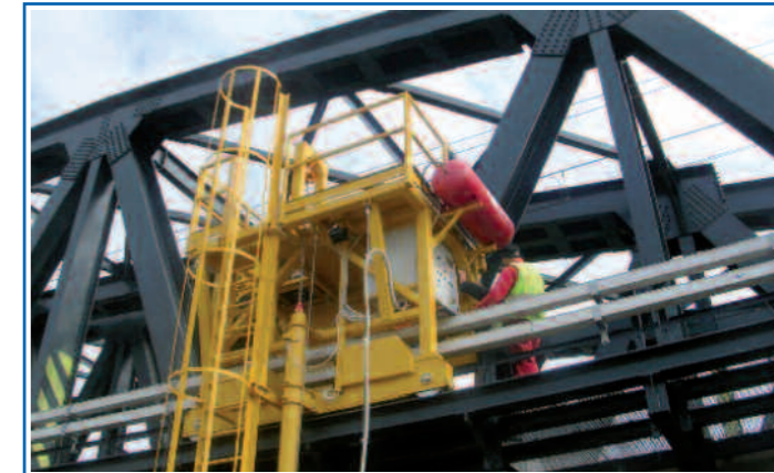
Piattaforma di servizio per il nuovo ponte sul PO della Linea Bologna Verona (Brevettata) - Nessuna interferenza con il traffico.
