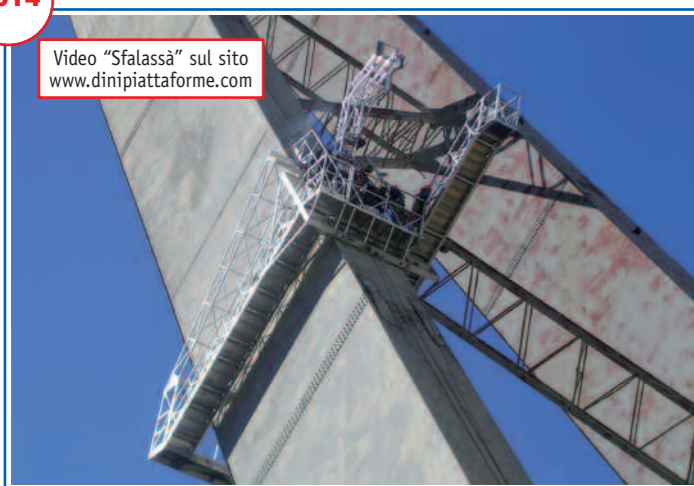
Piattaforma "Marta" per la manutenzione straordinaria dei puntoni e dei tralicci di collegamento del viadotto "Sfalassà" dell'autostrada A3 Salerno - Reggio Calabria
