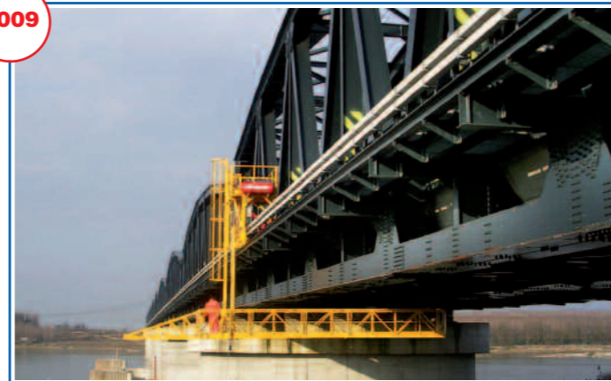
Piattaforma di servizio per il nuovo ponte sul PO della Linea Bologna Verona (Brevettata) - Nessuna interferenza con il traffico.
