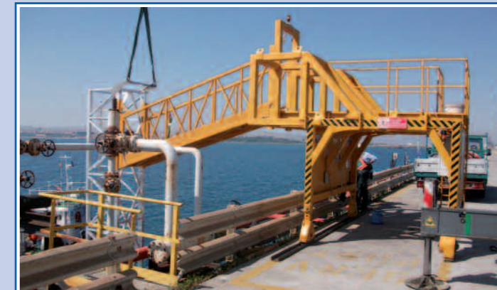
N. 2 piattaforme utilizzate per i lavori di sostituzione della linea P2 sul pontile della raffineria ENI di Gela. È particolarmente interessante per lo sbalzo laterale di quasi 5m.
