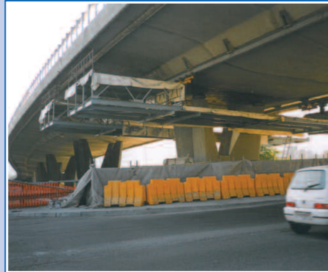
Sistema di piattaforme scorrevoli per il risanamento del viadotto di Bolzano dell'autostrada A22 Brennero-Modena. Gli obiettivi raggiunti sono stati: modularietà (utilizzo singolo o multiplo di moduli da 5,5x22 m), area totale di 2.200 mq, portata 150 kg/mq, scorrimento su rotaie applicate al viadotto, superamento delle pile in quota (Brevettata).
