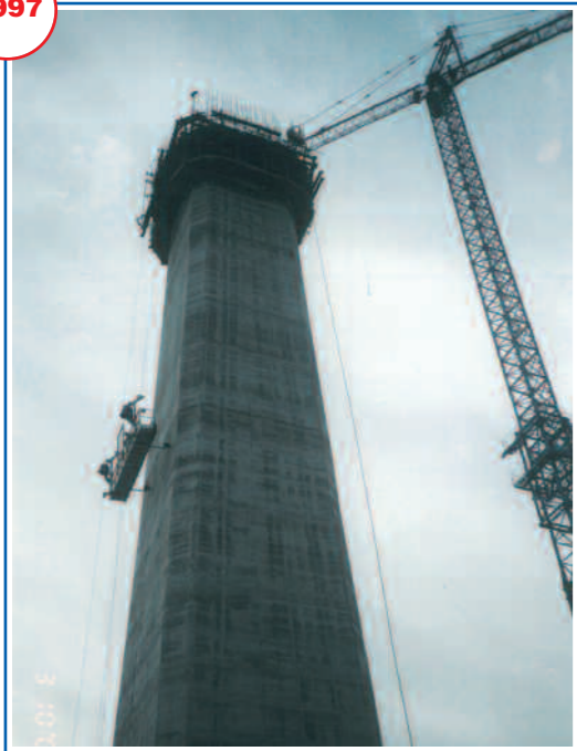
Piattaforma per accesso al cassero rampante. Costruzione viadotto "Castel di Tusa" Autostrada A20 Messina Palermo
