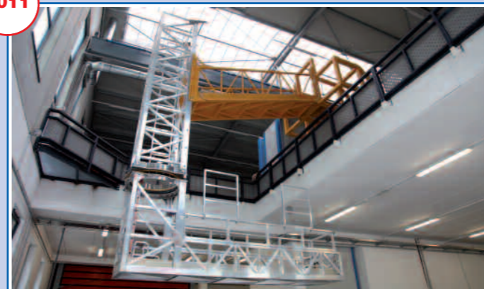
N. 2 piattaforme utilizzate per i lavori di sostituzione della linea P2 sul pontile della raffineria ENI di Gela. È particolarmente interessante per lo sbalzo laterale di quasi 5m.
