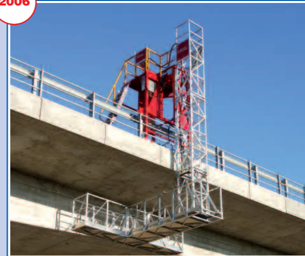
Piattaforma "per le travi di bordo" (Brevettata). Lo spazio richiesto sulla carreggiata è di solo 1,39 m che può essere ridotto posizionando il carro "a cavallo" della barriera.
