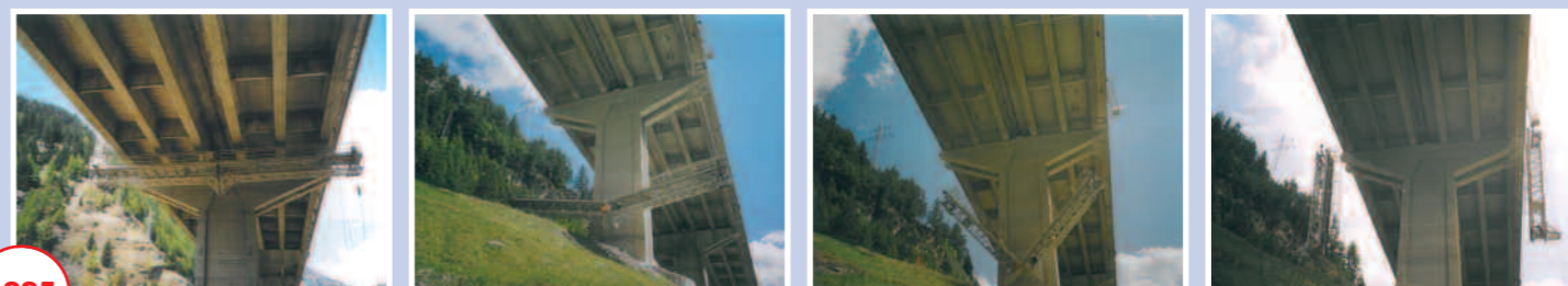
Piattaforma elettrica a funi da 26,40x2,40 mt. Sequenza delle manovre per il passaggio della pila. Viadotto "Ponticolo" Autostrada A22 Modena-Brennero
