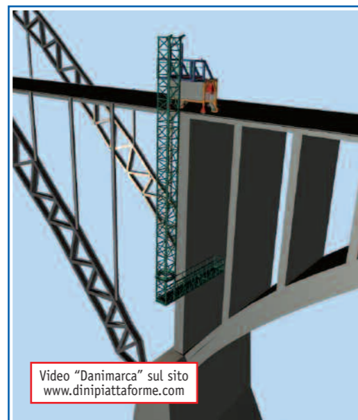
Piattaforma semovente a torre con estensione massima verso il basso di 15 mt, per la manutenzione di un ponte in Danimarca
