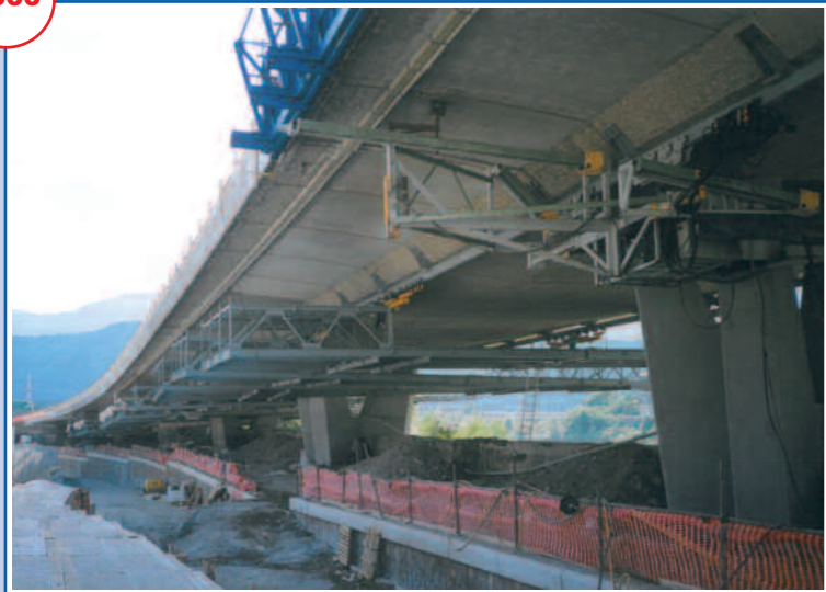
Sistema di piattaforme scorrevoli per il risanamento del viadotto di Bolzano dell'autostrada A22 Brennero-Modena. Gli obiettivi raggiunti sono stati: modularietà (utilizzo singolo o multiplo di moduli da 5,5x22 m), area totale di 2.200 mq, portata 150 kg/mq, scorrimento su rotaie applicate al viadotto, superamento delle pile in quota (Brevettata).
