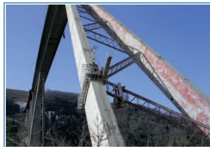
Piattaforma "Marta" per la manutenzione straordinaria dei puntoni e dei tralicci di collegamento del viadotto "Sfalassà" dell'autostrada A3 Salerno - Reggio Calabria
