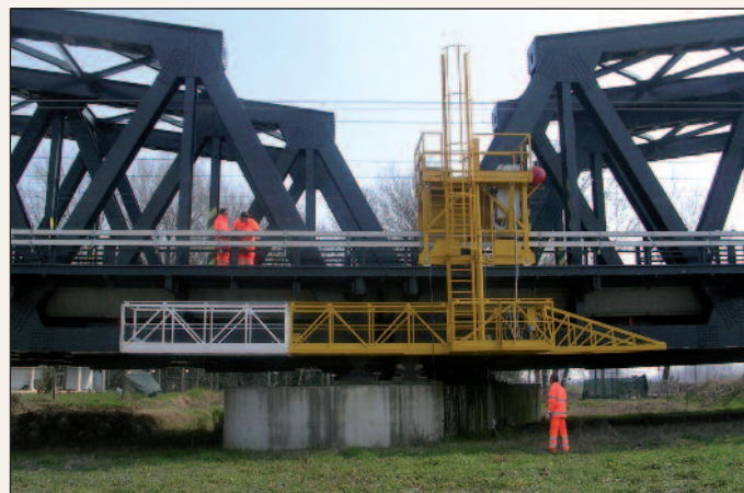
Figura 3 - La piattaforma trasla sopra la testa della pila
