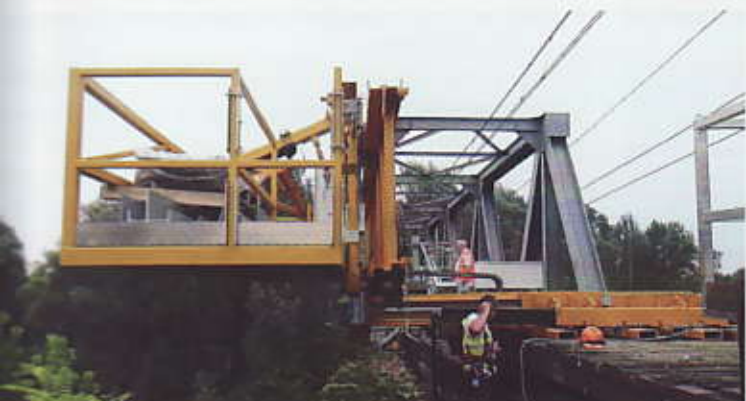
7. La piattaforma in funzione: sulla sinistra l'attrezzatura B, sul carro l'attrezzatura A
