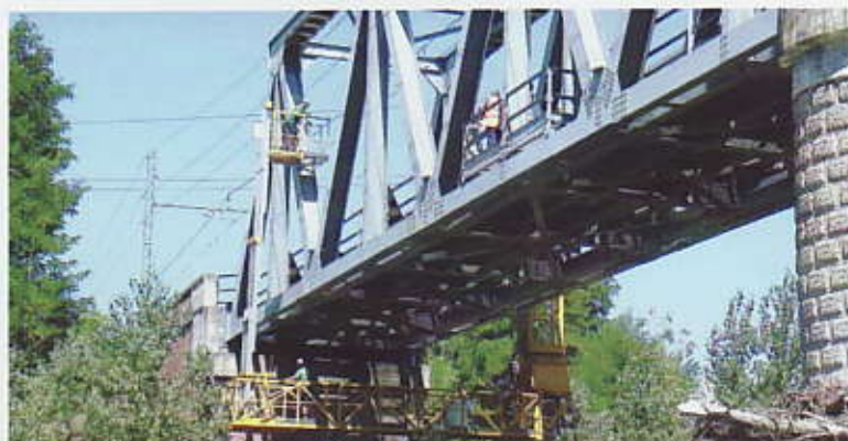
8. Piattaforma in posizione trasversale alla travata con lift elevato
