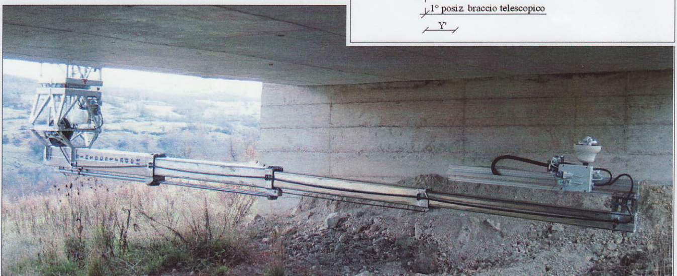
Figura 4 - Il braccio estensibile con la telecamera ispeziona la struttura sottoponte
